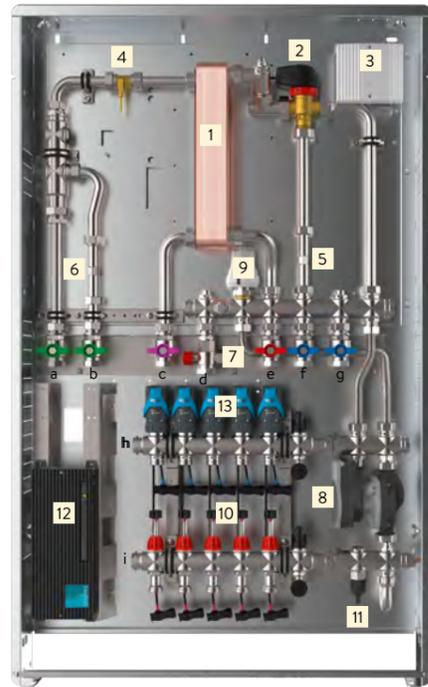
Die Wohnungsübergabestation WS-Smart mit integriertem Heizkreis und Plattenwärmetauscher dient der hygienischen Trinkwasserversorgung und zusätzlich der Versorgung und Regelung von Flächenheizungen mit Festwertregler 20 – 50 °C mit integrierter Pumpe.
